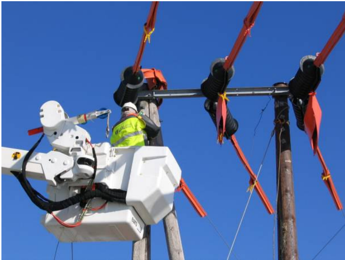
-Skifting av mast, 22kV
