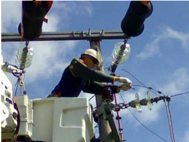
-Tilkobling av avgrening, 22 kV
